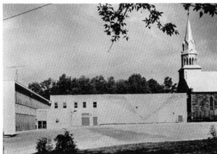
8 Mur extérieur de gymnase, 1985 brique École St-Jean-Baptiste de Roxton Falls, Québec
